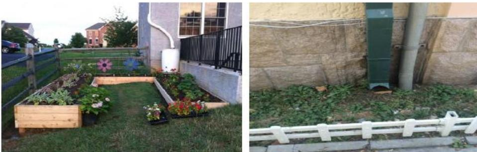
落水管断接示意图
